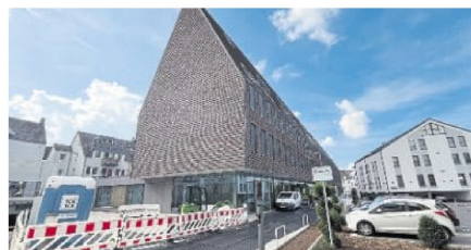
Die letzten Bauarbeiten am VG-Rathaus sind im Gange. Im November soll die Verwaltung umziehen.
